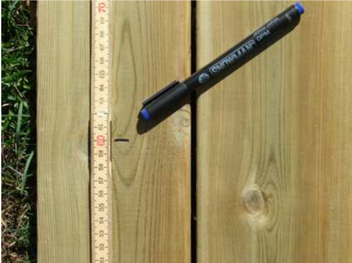
Gör markeringar var 60:e cm utifrån mittenstrecket
