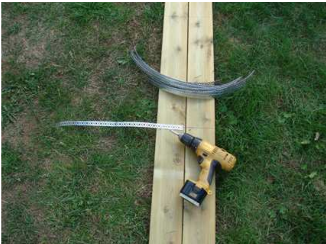
Klipp till spikband i 60 cm längder
