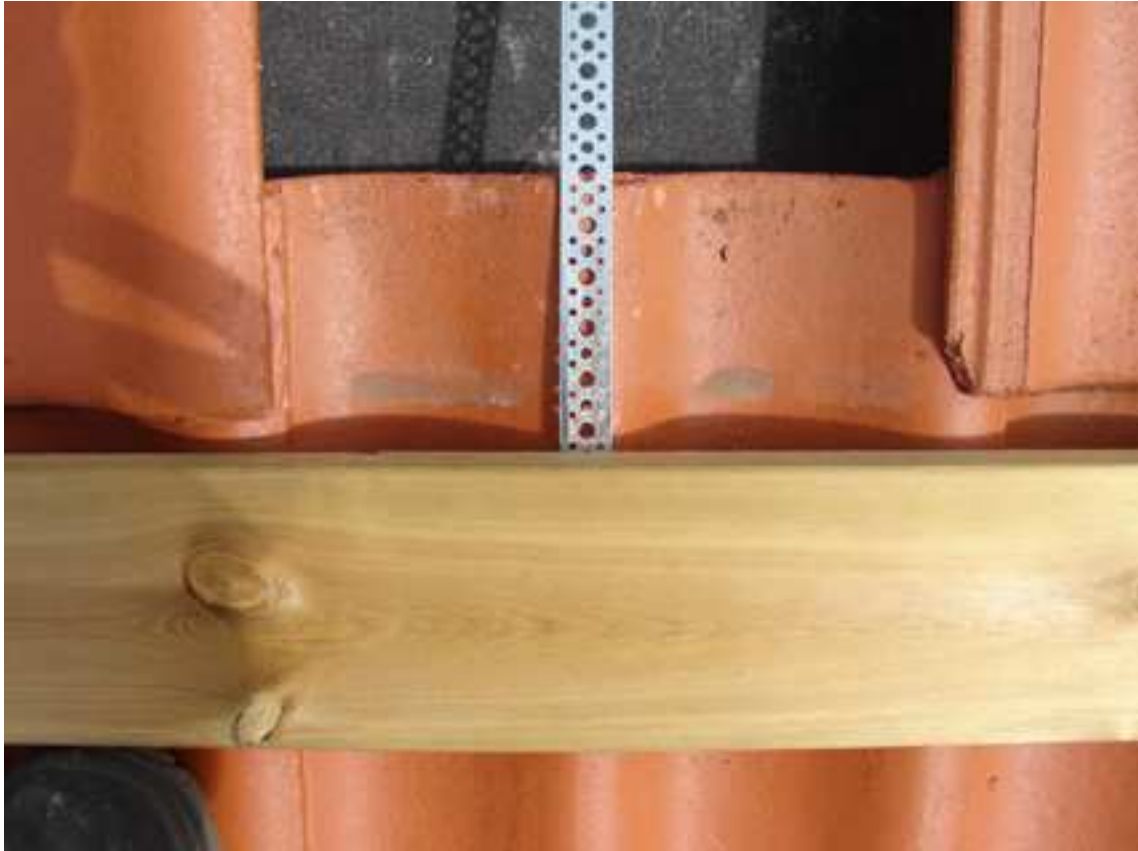
Placera brädan någon cm under raden av takpannor
