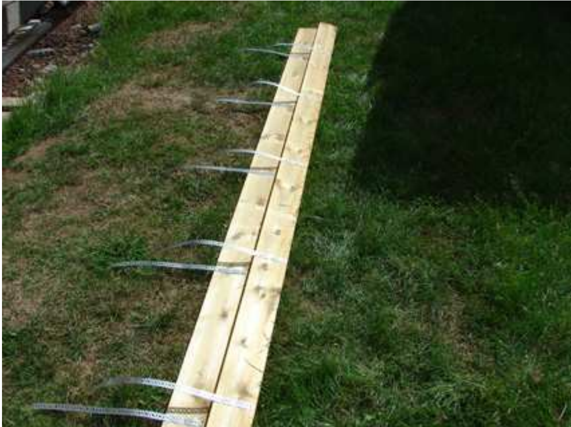
Skruva fast spikbanden på varje markering på brädorna
