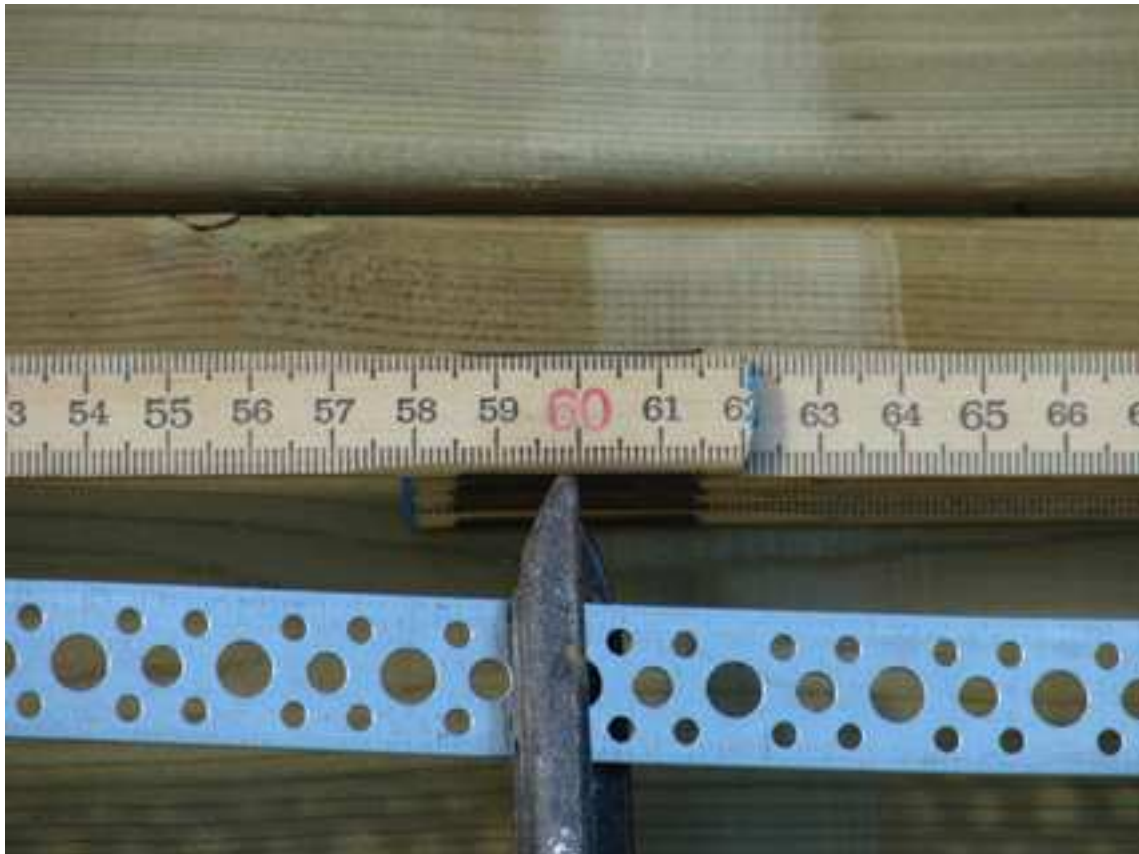
Klipp till spikband i 60 cm längder
