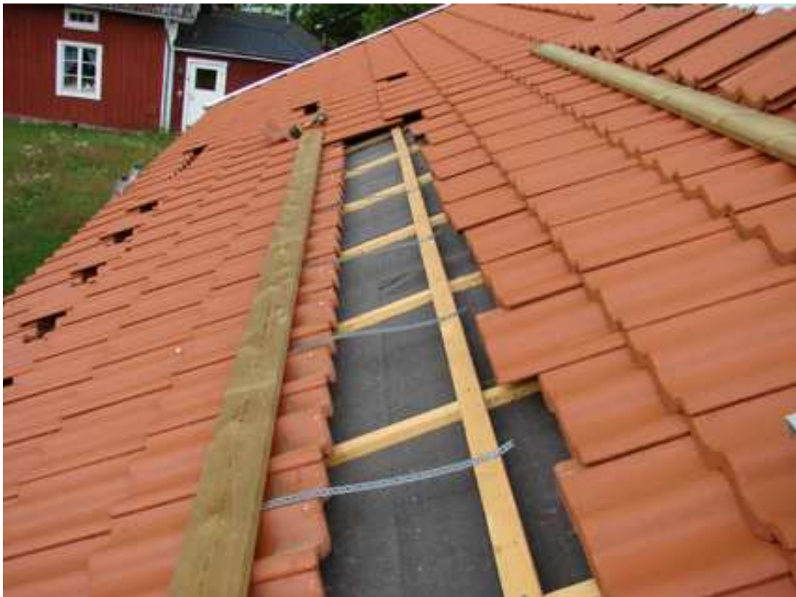
Placera brädan någon cm under raden av takpannor
